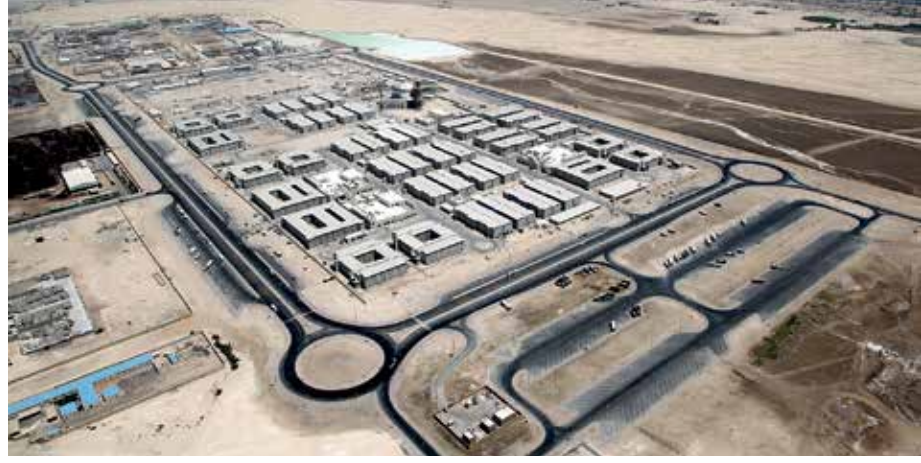
26 bin kişilik işçi yerleşim şehri - Abu Dhabi
