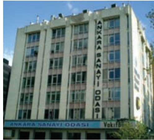
ASO'nun Atatürk Bulvarı 193 Numaradaki Eski Binası
