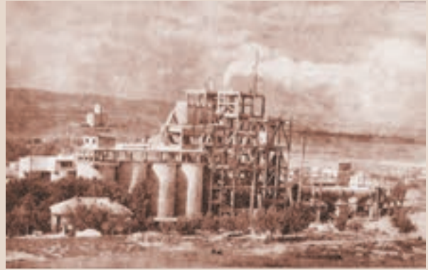
Ankara Çimento Fabrikasının Genel Görünüşü
