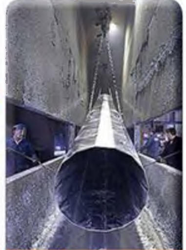
Sıcak Daldırma Galvaniz
