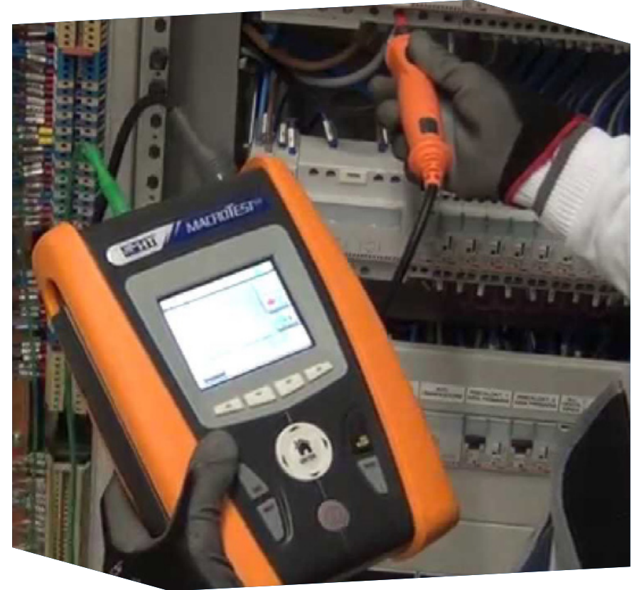
Trafo Merkezlerindeki Topraklama Test Çalışmaları
