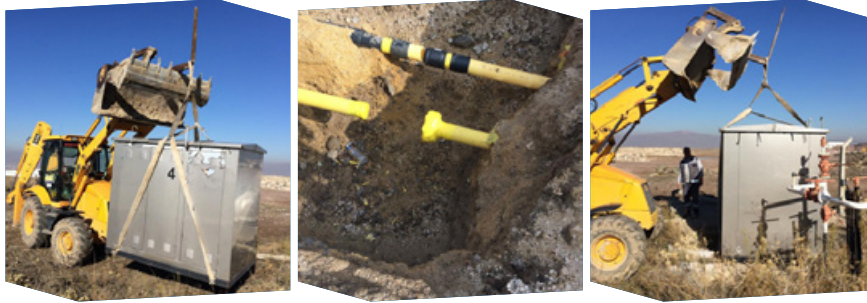
Doğalgaz İstasyonunun Taşınması Çalışmaları
