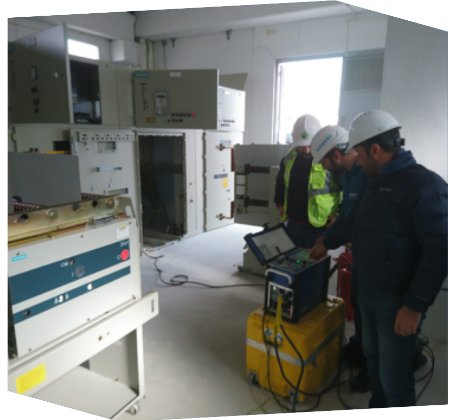
Yıllık Elektrik Şebekesi Altyapı Bakım-Onarım ve Test Çalışmaları
