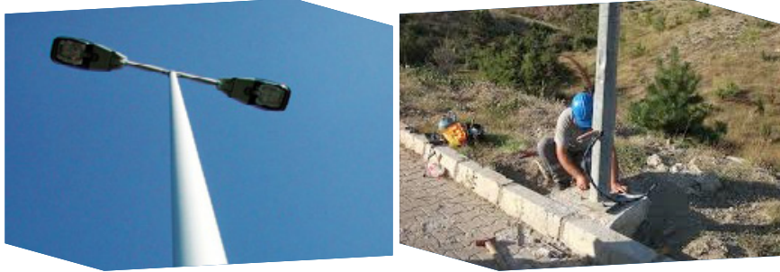
Aydınlatma Direk Ve Armatür Değişim Çalışmaları
