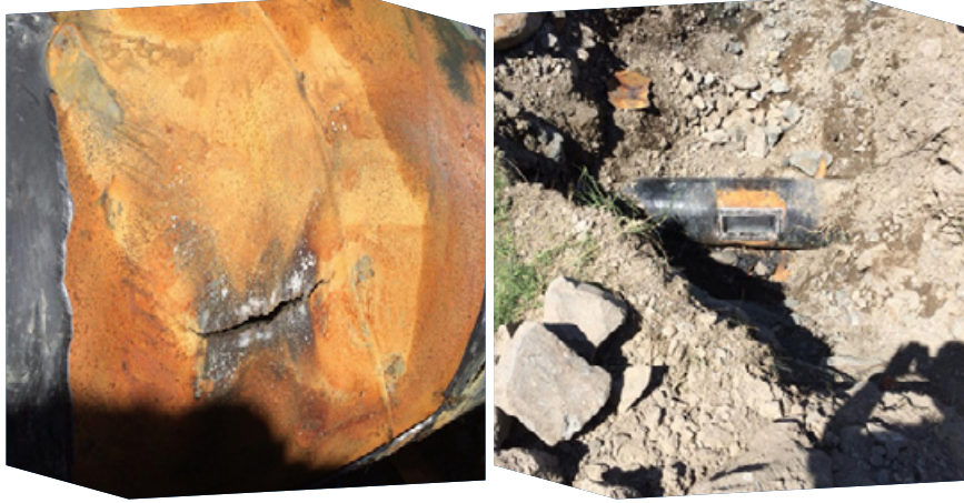
Çelik Boru Çatlağı ve Tamiri
