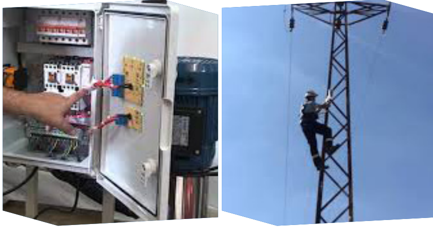
Kuyular Bölgesi Elektrik Şebekesi Bakım Onarım Çalışması
