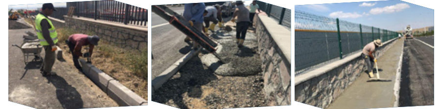
Yaya Yolu Yapım Çalışmaları
