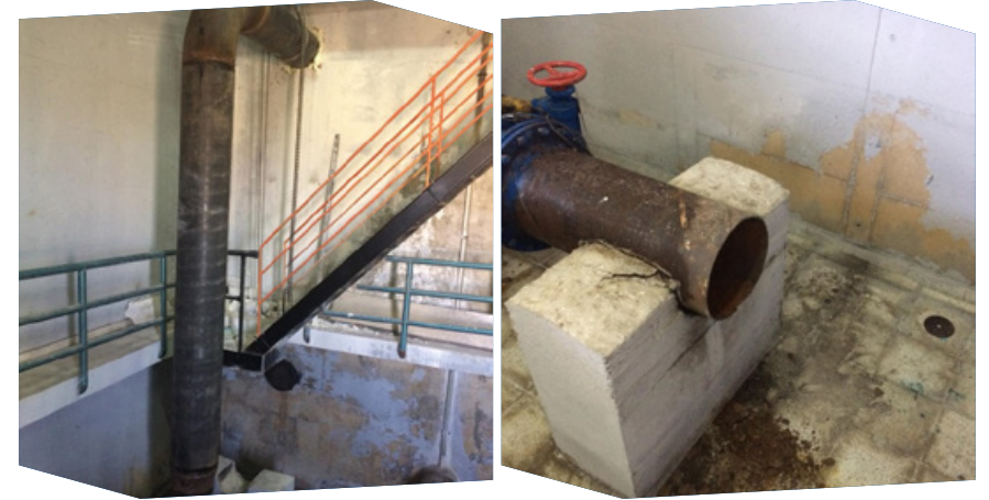
Sonra "Su Deposu Dolum Hattı Tadilat Çalışması" Önce
