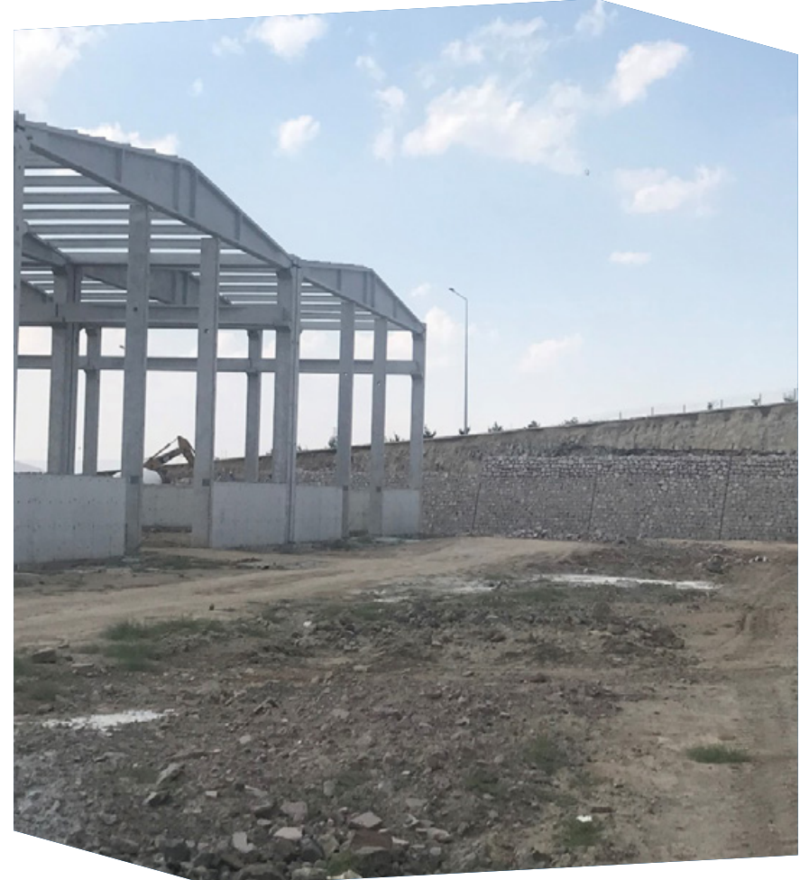
Altyapı Koruma Amaçlı İstinat Duvarı Yapımı
