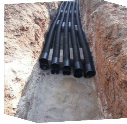
Enerji Nakil Hattı Borulama Çalışmaları
