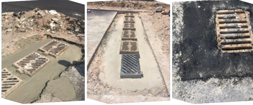
Yağmur Izgarası ve Rögar Kapağı Yükseltme Çalışmaları
