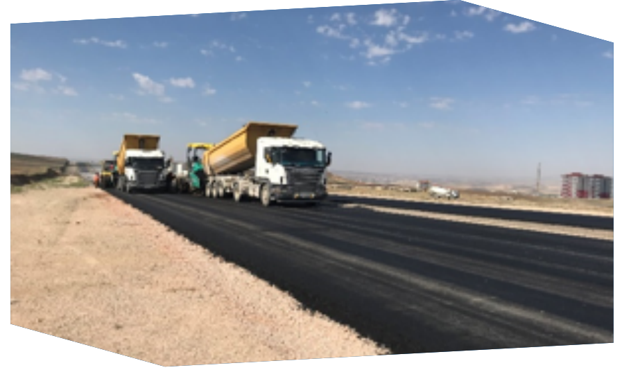
Eskişehir Bağlantı Yolu Asfalt Çalışmaları
