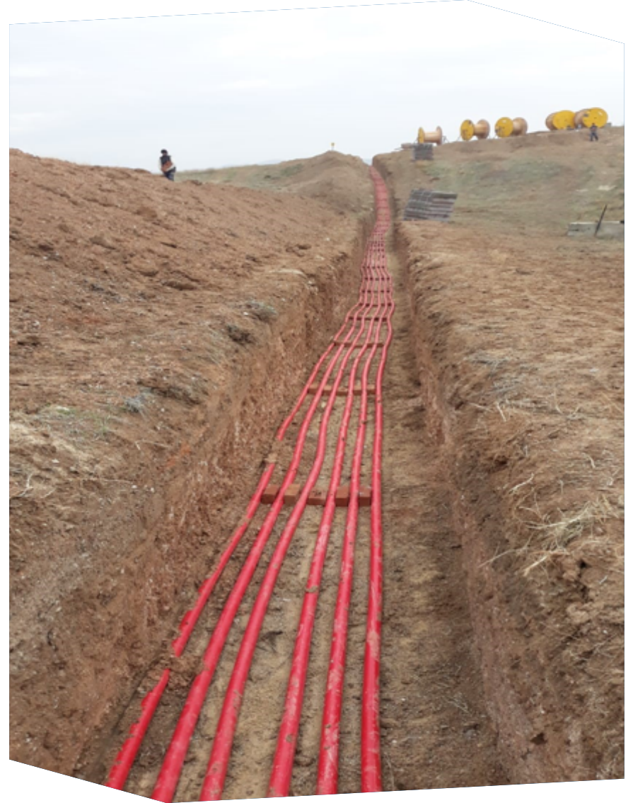
Enerji Nakil Hattı Kablosu Montaj İşlemi
