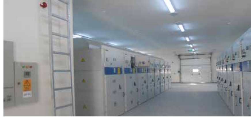
BÖLGEMİZE TAHSİS EDİLMİŞ 8 FİDERİN BULUNDUĞU 380/33 KV TRAFİ MERKEZİ
