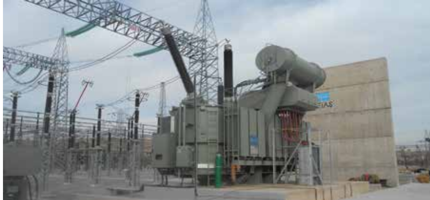
SİNCAN TRAFİ MERKEZİNE TESİS EDİLEN 380/33 KV 125 MVA TRAFİ
