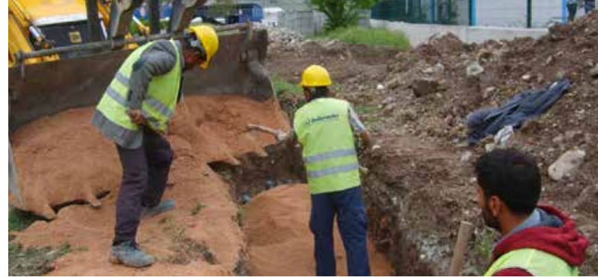
DALKIRANLAR BORULAMA VE KABLOLAMA ÇALIŞMALARI
