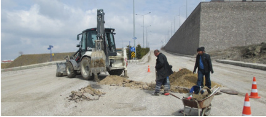
Altyapı tamamlama işleri, yağmursuyu parsel bağlantısı çalışması
