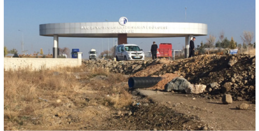
Yağmursuyu Drenaj Hattı
