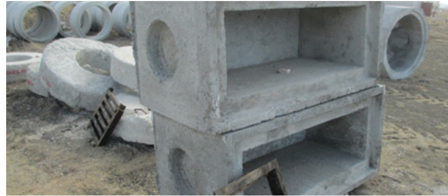
Altyapı Tamamlama İşleri, İlave Yağmursuyu Izgara Tabanları
