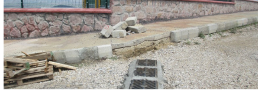
Altyapı Tamamlama İşleri, İlave Yağmursuyu Izgaralarının Yapılması
