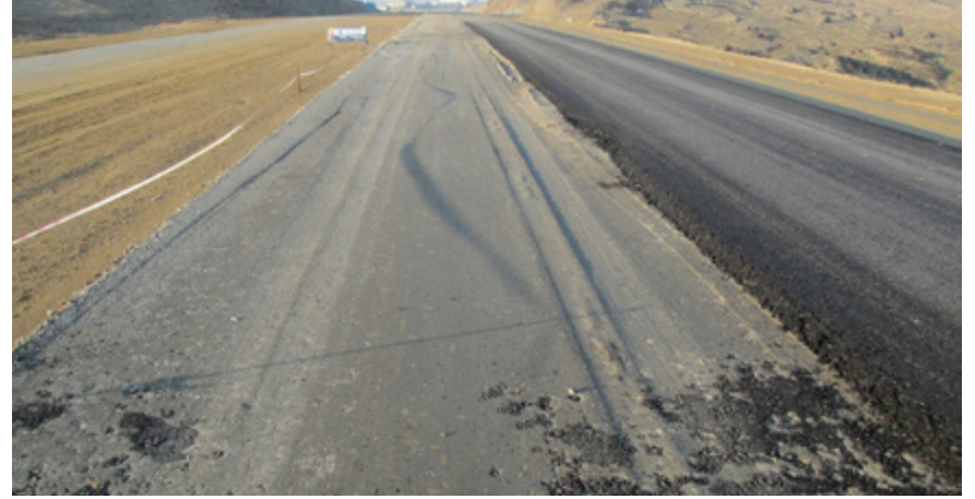
Eskişehir yolu bağlantısı, Ankara Büyükşehir Belediyesi ekiplerinin yol yapım çalışmaları
