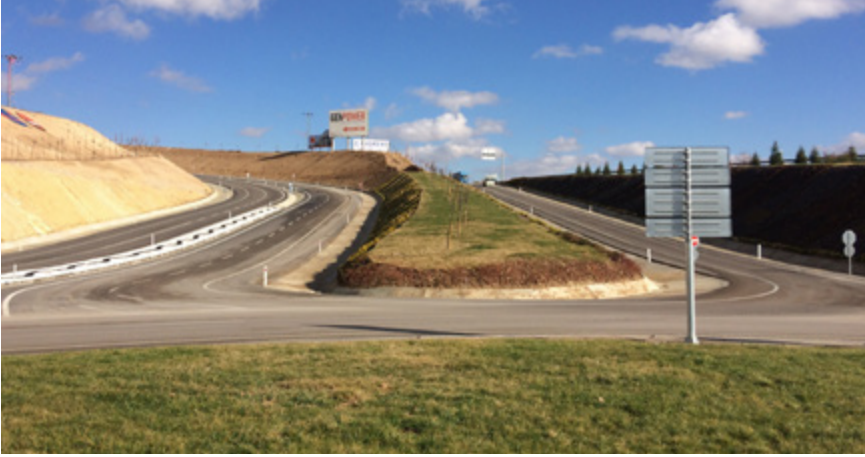
Eskişehir yolu bağlantısı, Karayolları 4. Bölge Alagöz Kavşağı yapım çalışmaları
