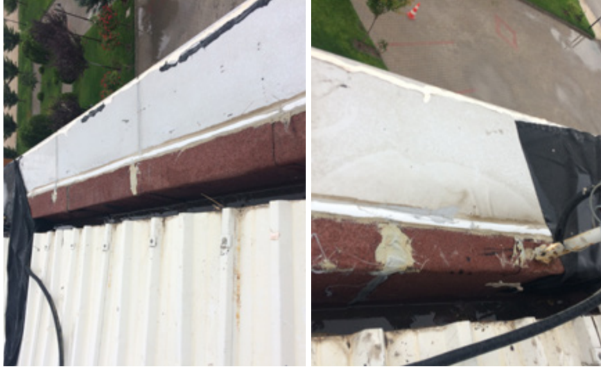
Çatının Eski Hali
