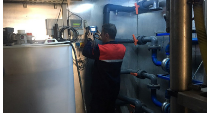
Atıksu Arıtma Tesisi
