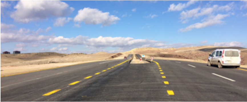
Eskişehir yolu bağlantısı, Ankara Büyükşehir Belediyesi yol yapım çalışması
