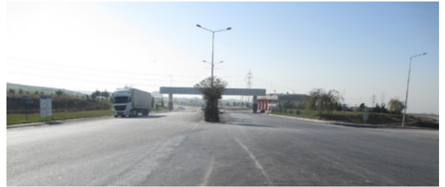
2010. Cadde ALCI Girişi, Tamamlanan Asfalt Kaplama Çalışması
