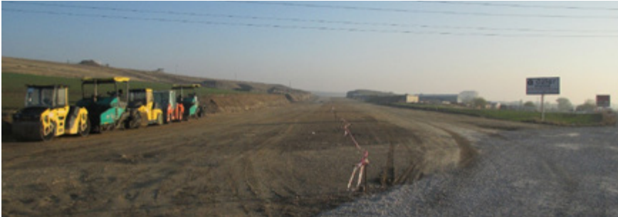
Eskişehir yolu bağlantısı, ALCI nizamıyesi önü, Ankara Büyükşehir Belediyesi ekiplerinin yol yapım çalışmaları
