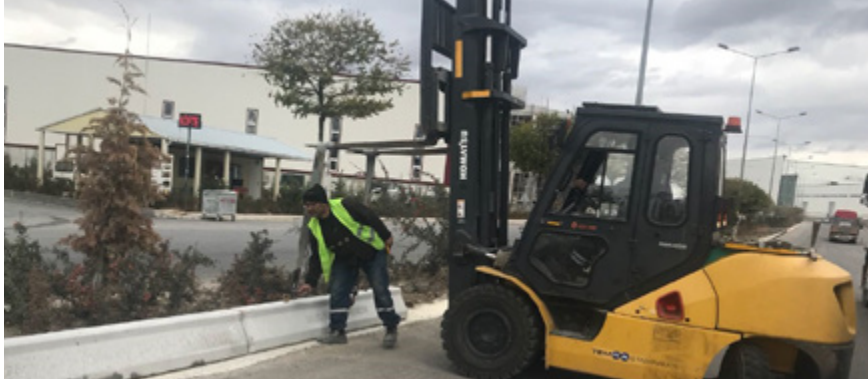
Refüj Yenileme Çalışmaları
