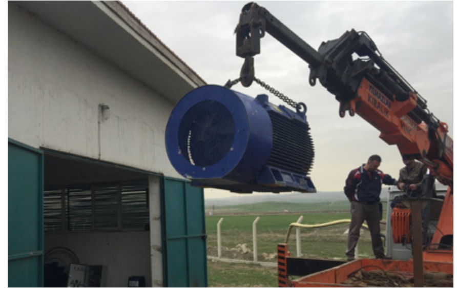
Su Pompalarının Montajı
