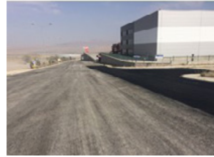
Bölge Yolları Asfalt Kaplama Çalışması
