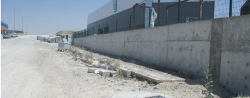
Altyapı tamamlama işleri, ilave yağmursuyu ızgaraları
