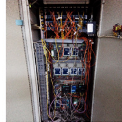
Eski RTU Panosu
