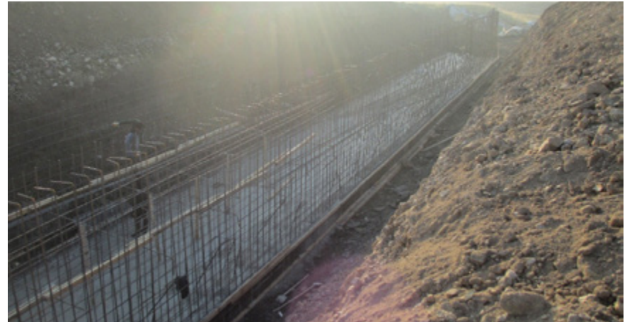
Eskişehir yolu bağlantısı, ALCI nizamıyesi önü, Ankara Büyükşehir Belediyesi ekiplerinin menfez yapım çalışmaları
