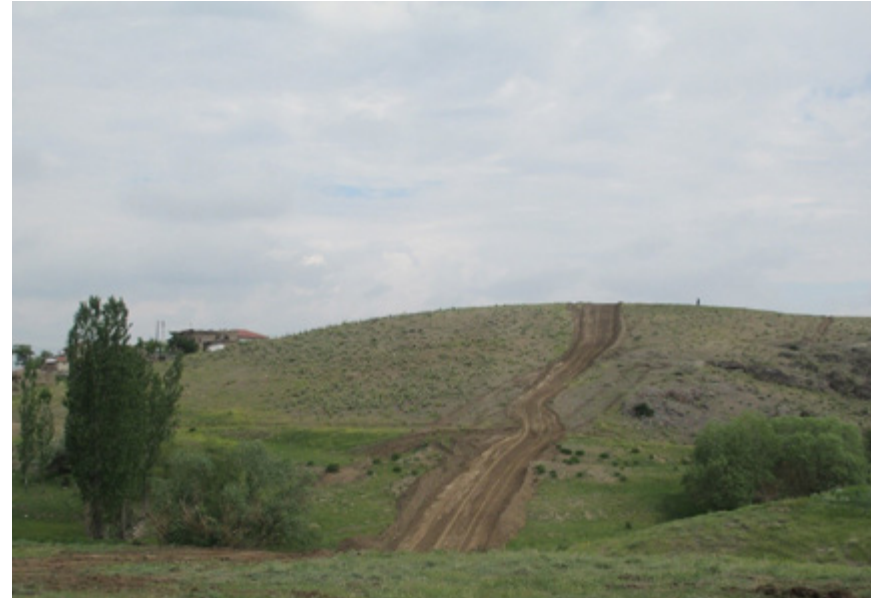
Eskişehir Yolu Bağlantısı, Ankara Büyükşehir Belediyesi Ekiplerinin Yol Yapım Çalışmalarının Başlaması
