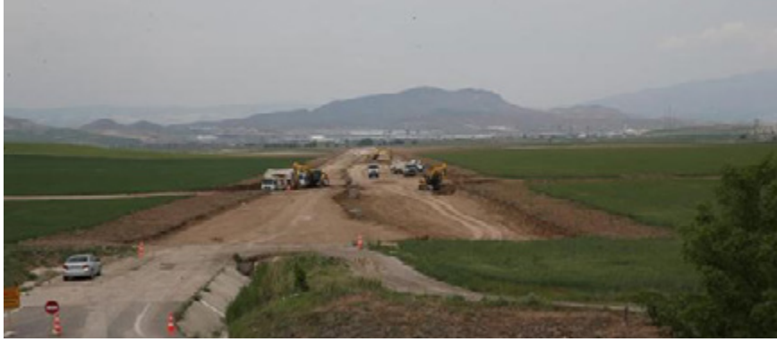
Temelli-Yenikent Çevre Yolu yapım çalışmaları
