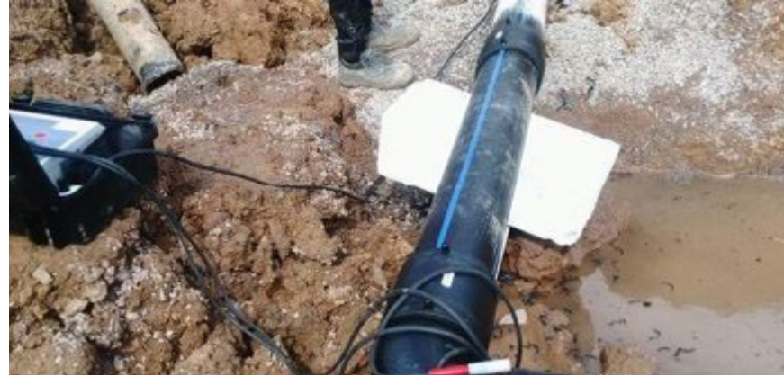
HDPE Boru Tadilatı
