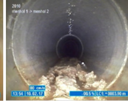
Kanalizasyon hattı iç görüntü
