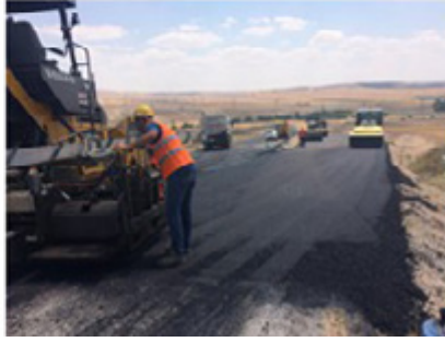
Bölge Bağlantı Yolu Düzeltme ve Asfalt Kaplama İşi
