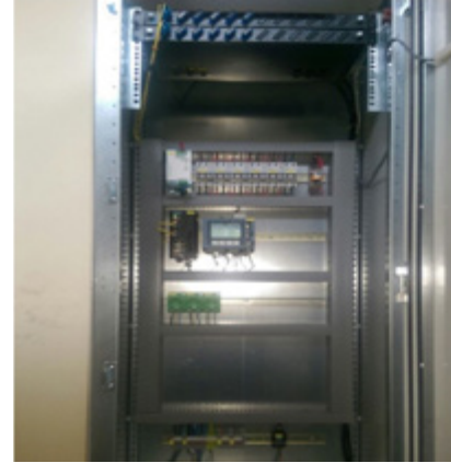
Yeni RTU Panosu
