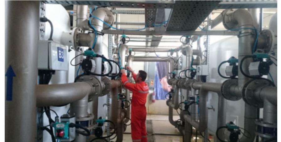
Su Arıtma Tesisi
