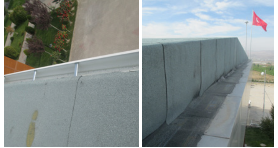
Çatının Yeni Hali
