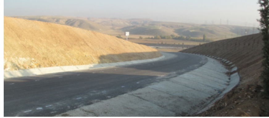
Eskişehir yolu bağlantısı, Karayolları 4. Bölge Alagöz Kavşağı yapım çalışmaları
