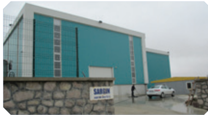
SARGIN İNŞAAT A.Ş.
